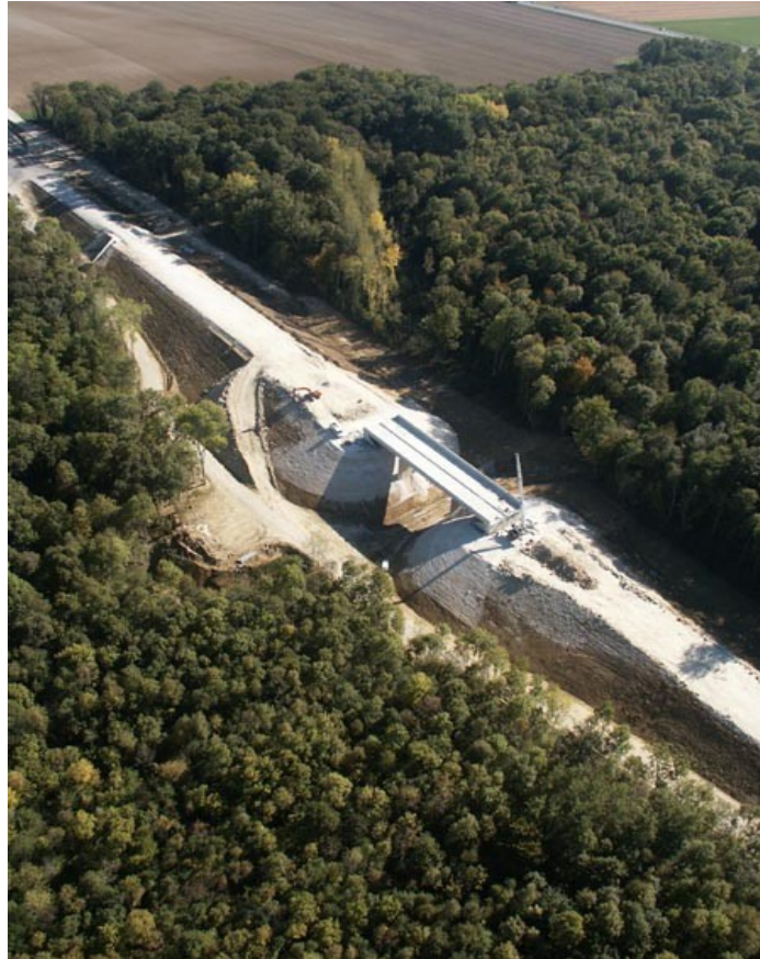
Ouvrage du bois de Triquenique ( Passage Grande Faune) - (Photo FNTP)
