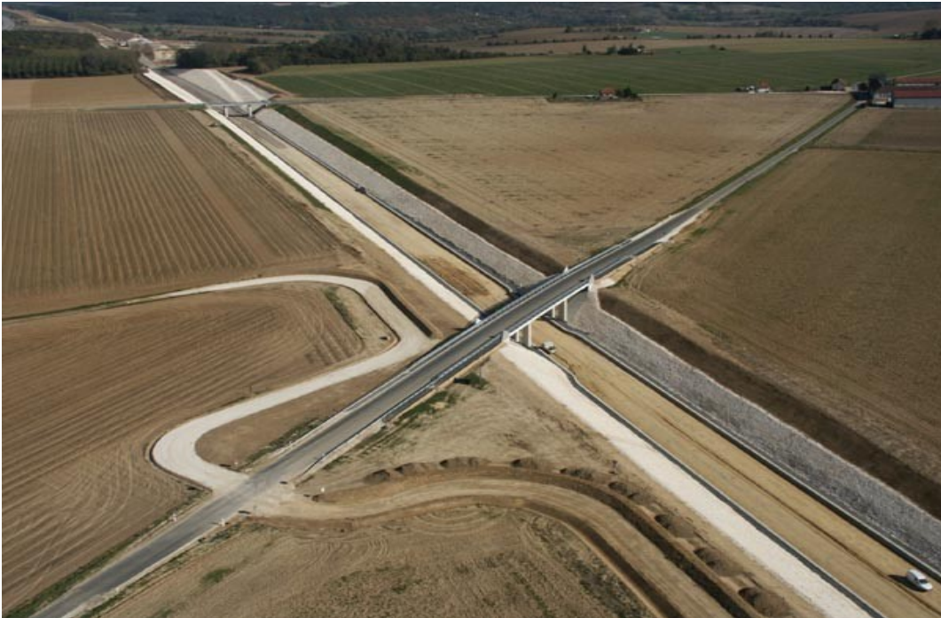
Franchissement de la RD 320 aux environs de Château-Thierry (Photo FNTP)
