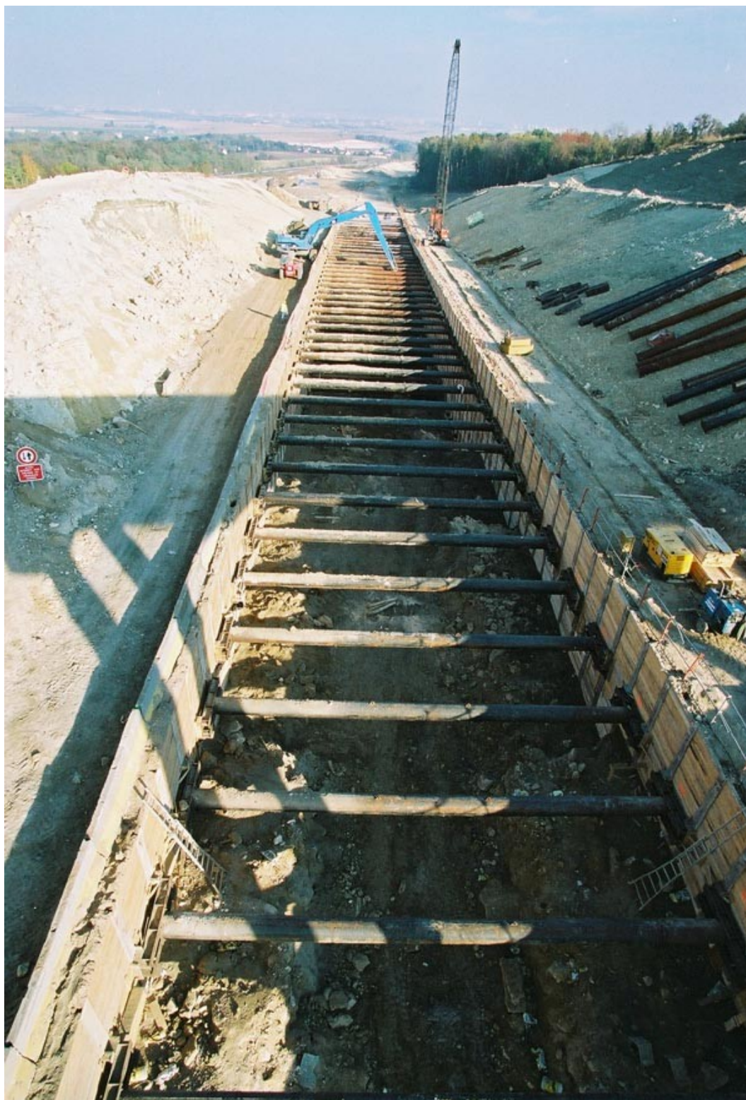
Terrassements de la tranchée ouverte (Photo FNTF)
