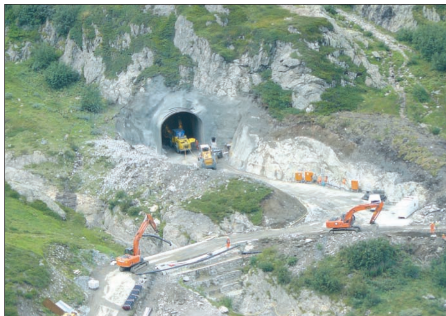
Image 5 - Excavation du portail d'Emosson (collecteur Ouest), août 2009.
