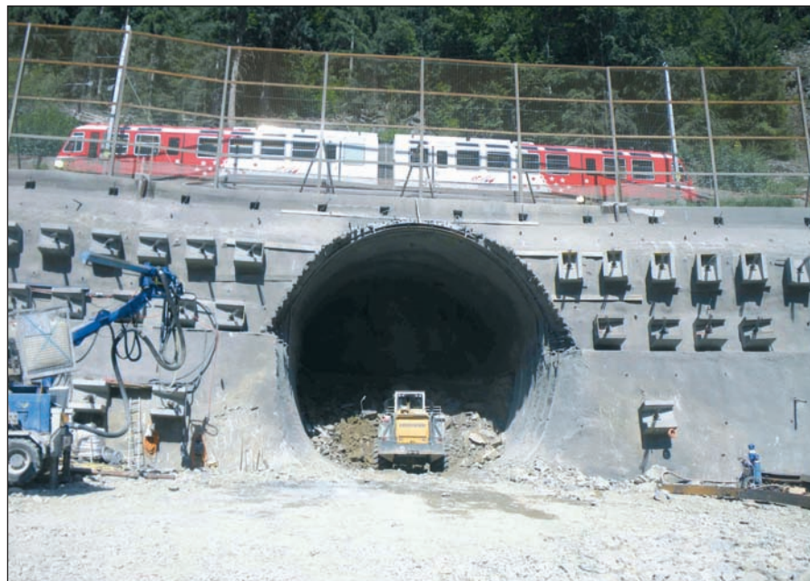
Image 4 - Excavation en terrain meuble au portail de la galerie d'accès principale, juillet 2009.
