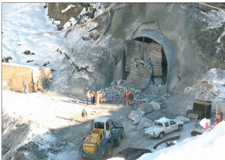
Image 2 - Début de l'excavation du tunnel d'accès Châtelard, décembre 2008.
