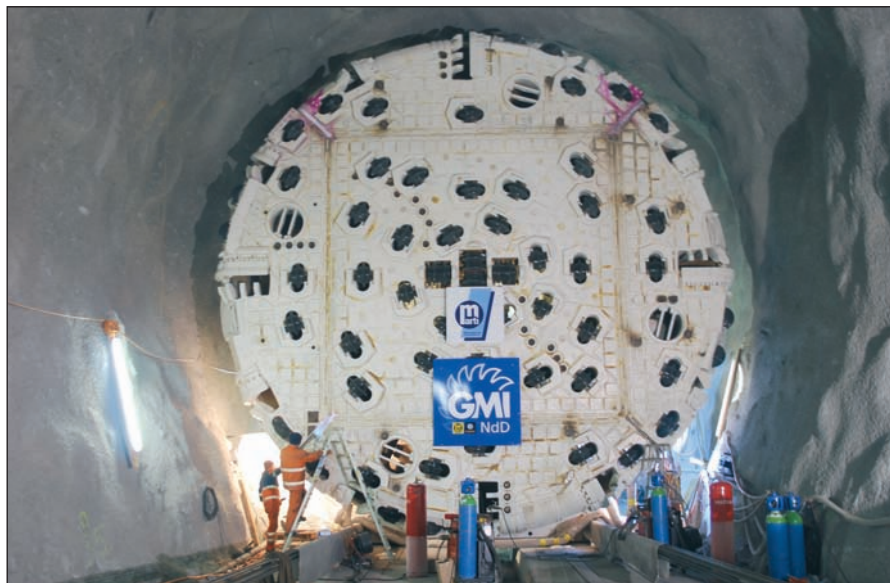
Image 6 - Tête du tunnelier en cours de montage, novembre 2009.
