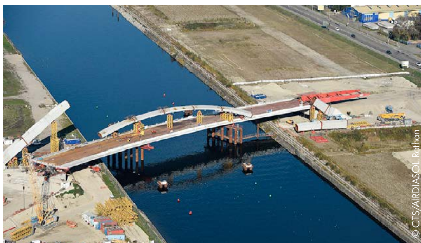
Lancement avec le tronçon central de l'arc
