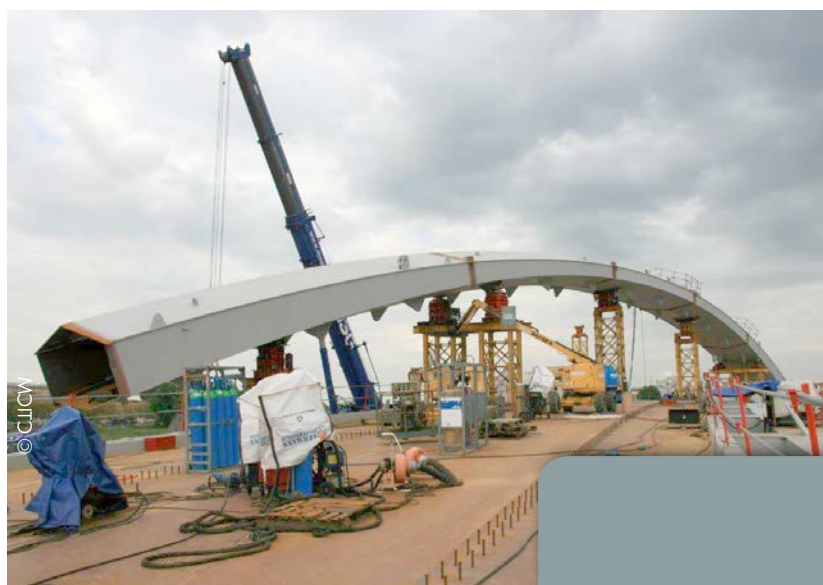
Platelage en phase de chantier
