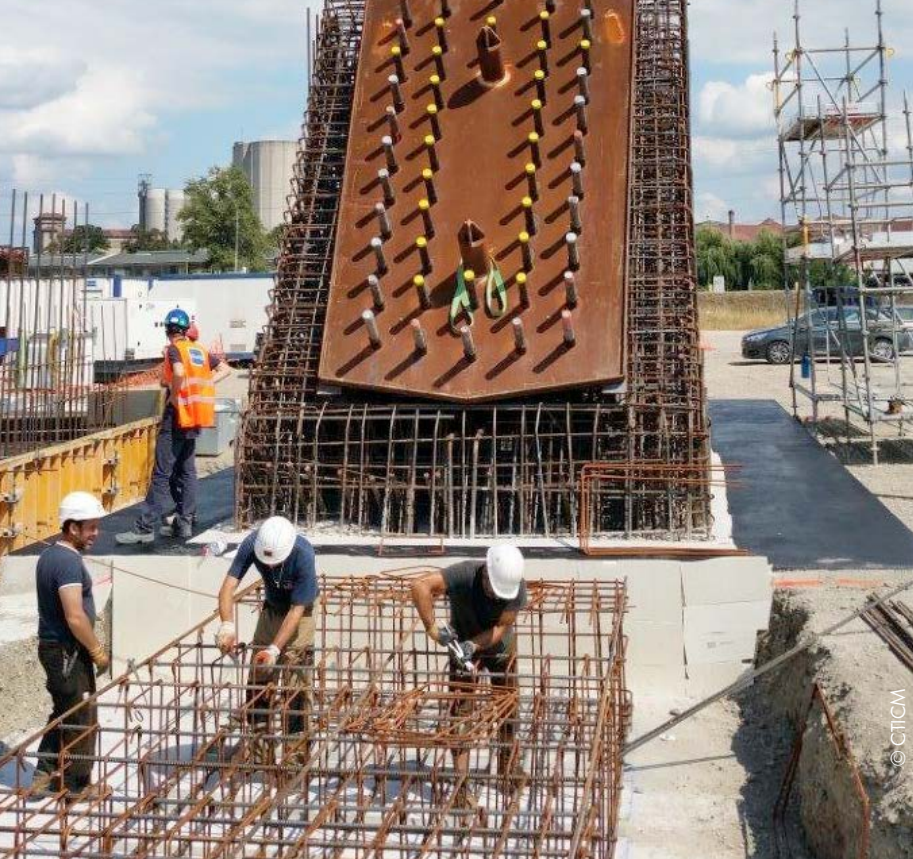
Platine d'encrage et ferrailage du pied de l'arc
