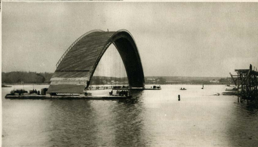
Le cintre est conduit à l'emplacement du premier arc.
