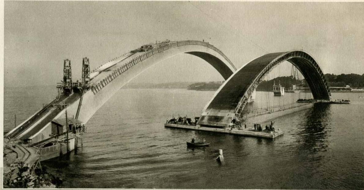
Déplacement du cintre quittant le 1 er arc pour aller à l'emplacement du 2 e arc.
