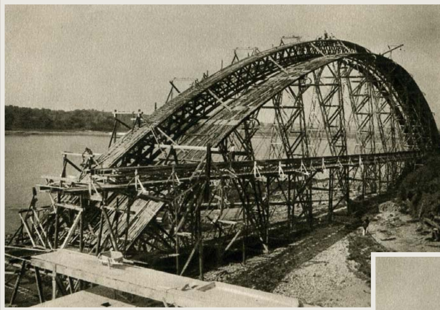
Construction du cintre
