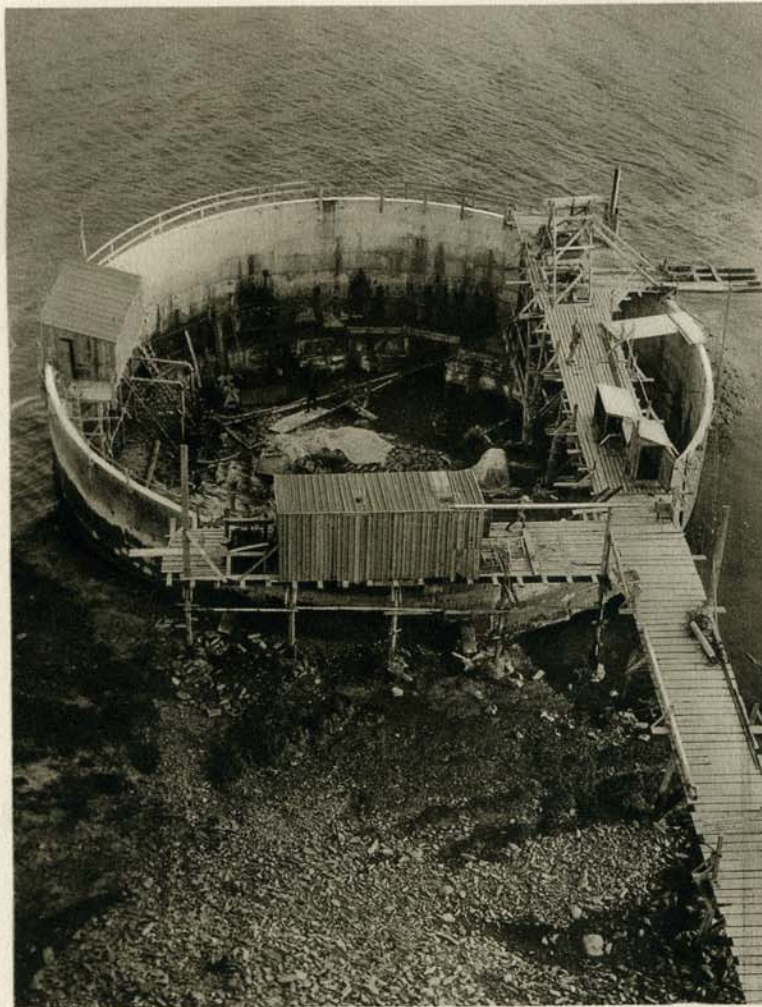
Le batardeau de la culée Brest.
