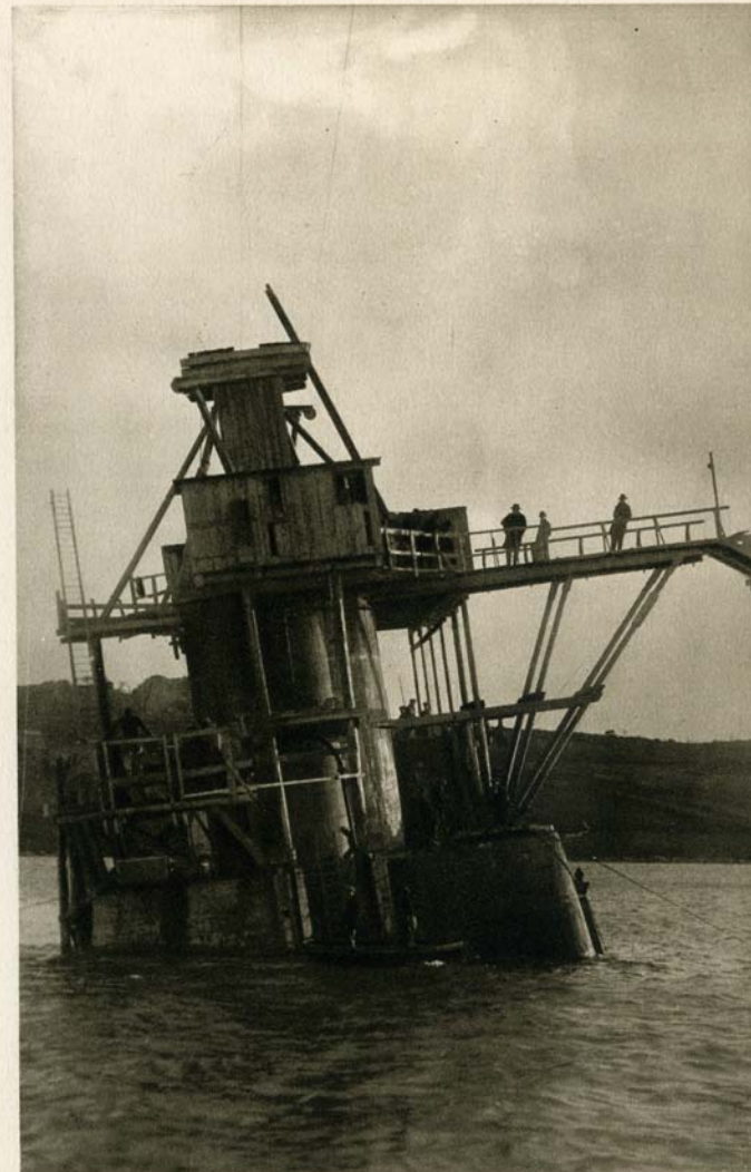
Sous l'influence d'un soufflage partiel, le caisson s'incline pour quitter la première pile dont la fondation est terminée.
