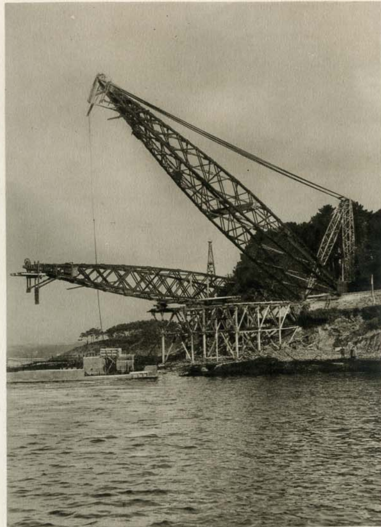
Le Transbordeur. — Levage des pylônes en bois de 55 mètres de hauteur supportant les deux câbles.
