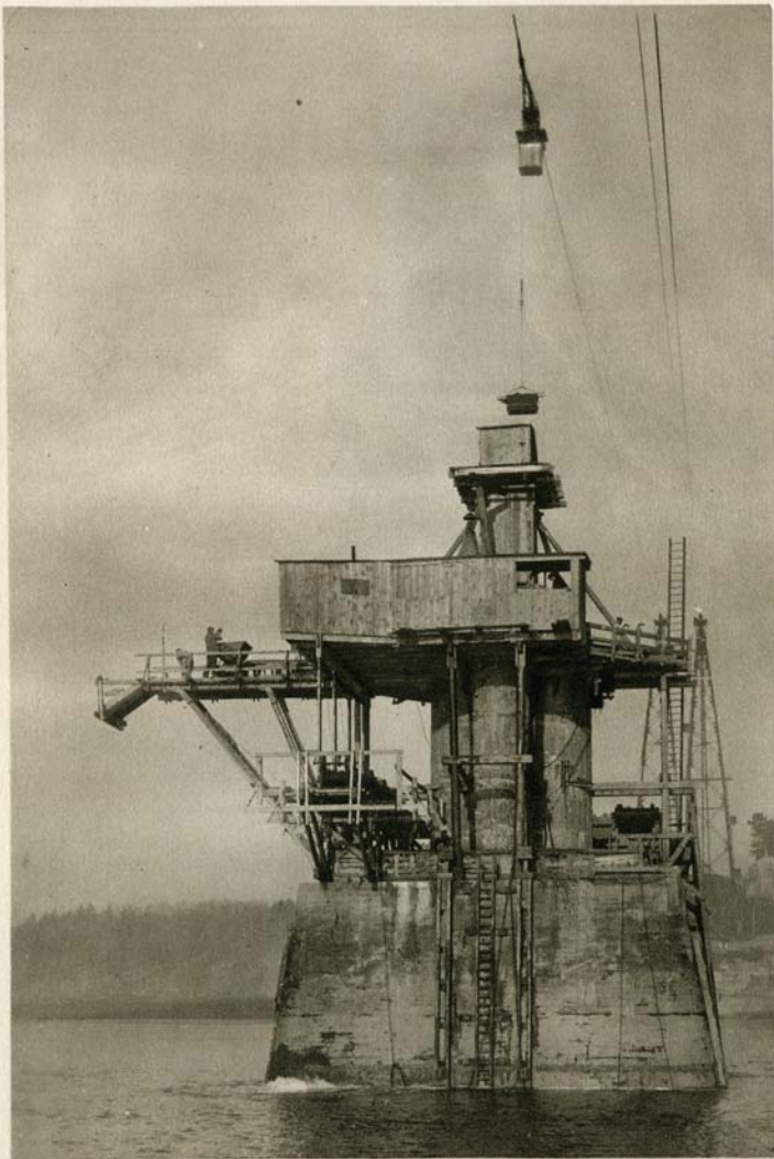
Le caisson fonctionnant en caisson-cloche sur la roche du Prince-Russe.
