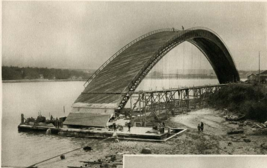
Le cintre est conduit à l'emplacement du premier arc.
