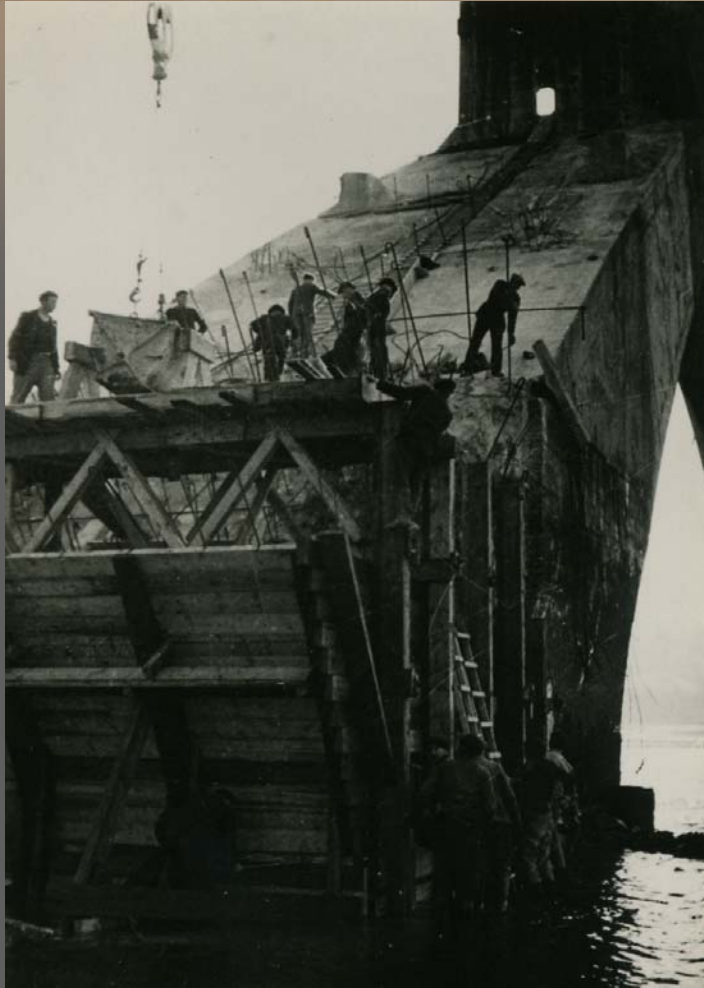
Travaux préparatoires sur pile
