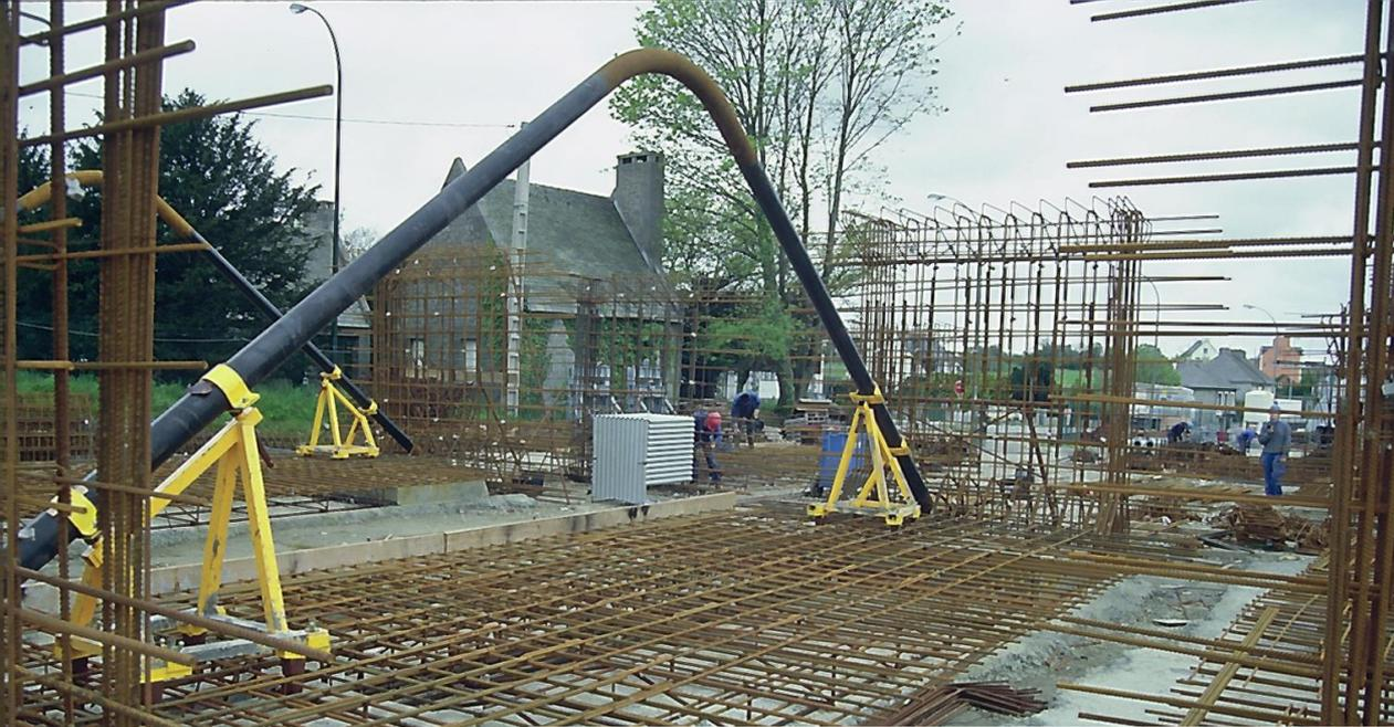
Préfabrication des cages d'armatures des voussoirs ou des plots incluant le tirant intérieur métallique
