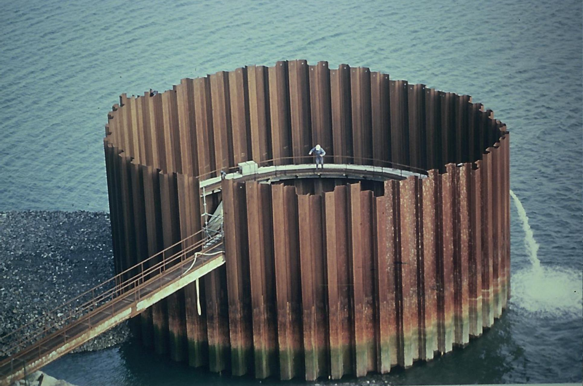
Le batardeau proprement dit en palplanches LVs, circulaire, de 16 m de diamètre
