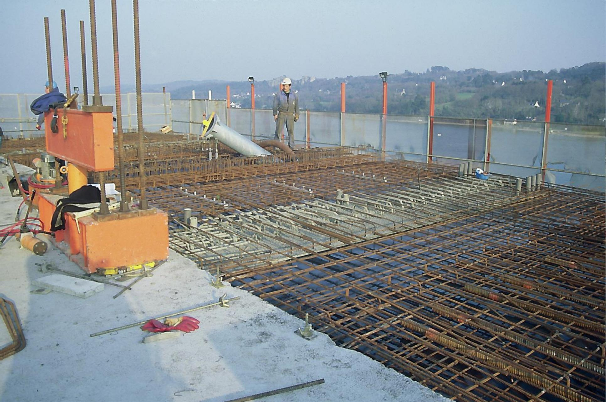
Ferrailage d'un voussoir courant, juste avant le bétonnage
