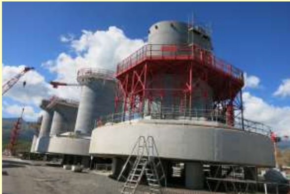
Préfabrication des piles au Port Est
