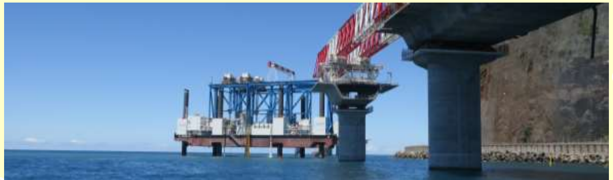
Pose en mer depuis la barge Zourite
