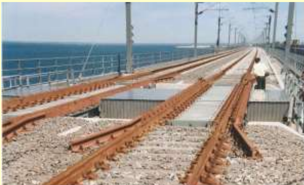
Viaduc du Storbelt
