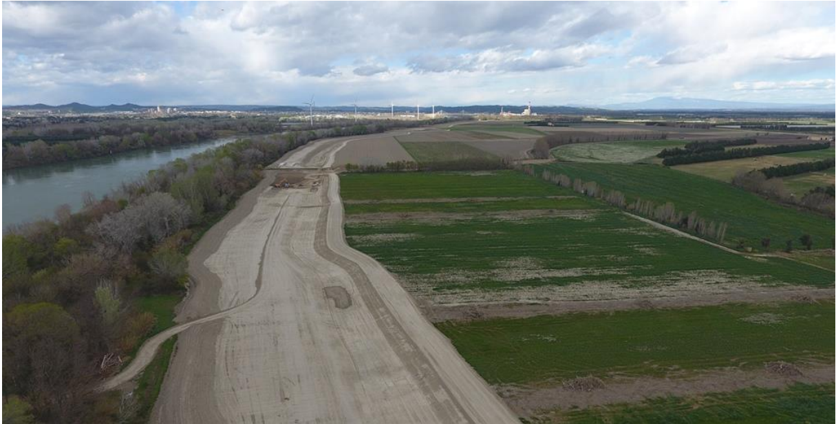
Terrassement de la lône sur 3,5 km
