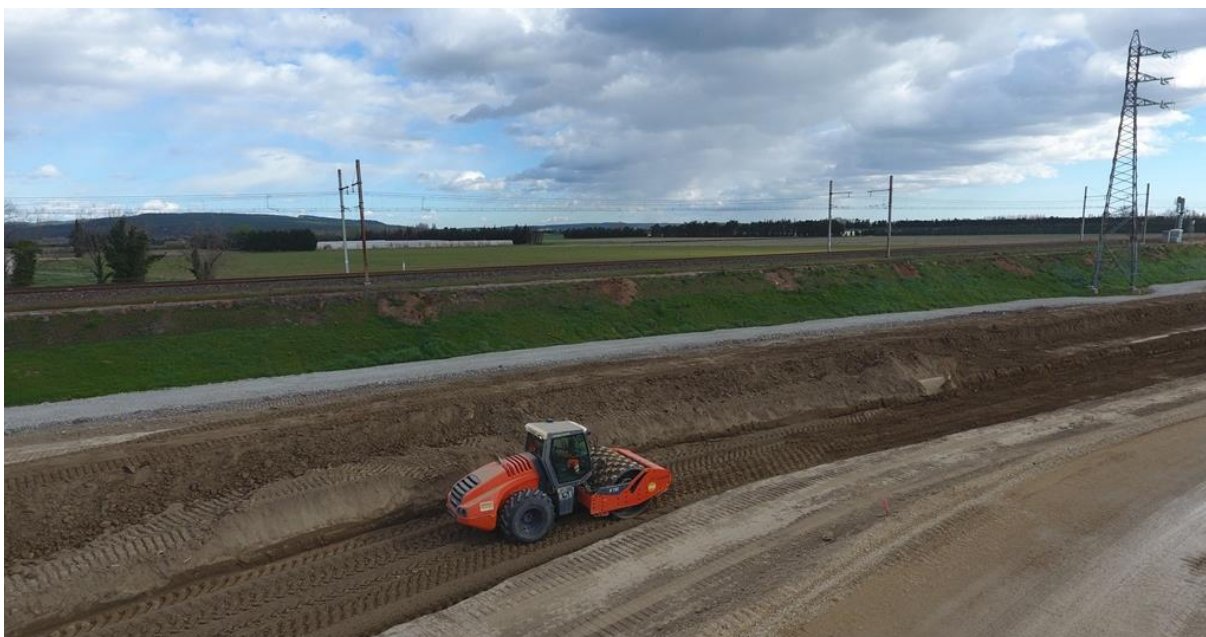
Compactage de la clé d'ancrage
