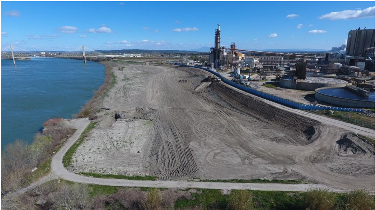
Terrassement de l'atterrissement
