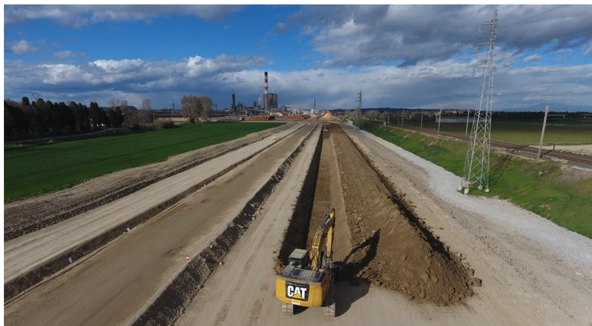
Réalisation de la clé d'ancrage
