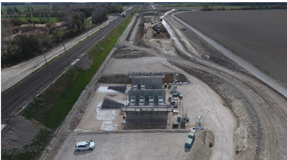
Réalisation des ouvrages de transparence hydraulique, qui seront ripés (en 4 phases) dans le remblai ferroviaire
