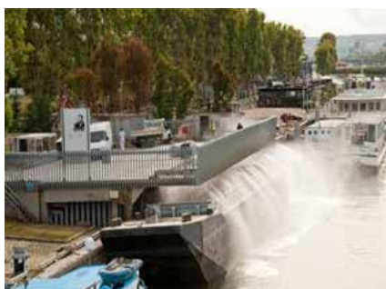
Brumisation des poussières
