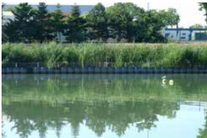
Renaturation des berges du Port de Bonneuil
