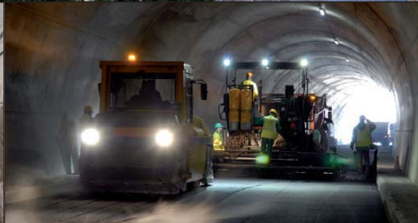
La chaussée a été réalisée dans les derniers mois du chantier. Cette étape a duré une semaine. L'engin au premier plan s'appelle le finisseur et permet d'étaler et de niveler le goudron.
