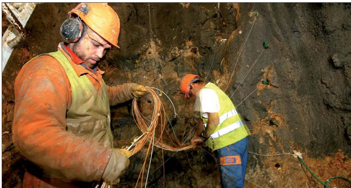
Les artificiers installent l'ensemble de détonateurs reliés au dispositif de mise à feu, quelques instants avant un tir de mines.
