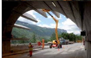
Le coffrage du tunnel a nécessité 20 000 m 3 de béton et une machine spéciale. Quatre couches d'étanchéité ont été posées avant le coffrage définitif en béton.
