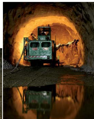
Cet engin de forage perce la roche grâce à ses trois bras articulés pour la mise en place des explosifs. En général, chaque tir permet l'avancée de 4 à 5 mètres.
