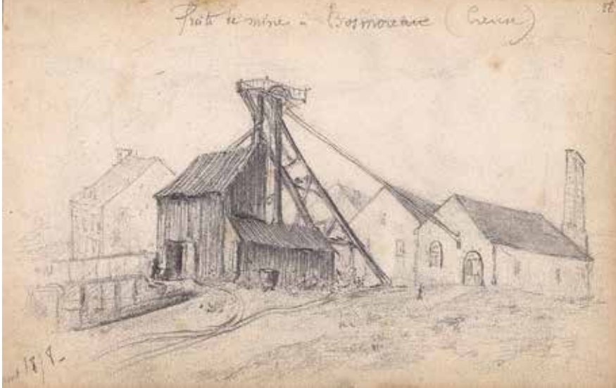
Puits de mine de Bosmoreau Henri Hugon. Bibliothèque numérique du Limousin
