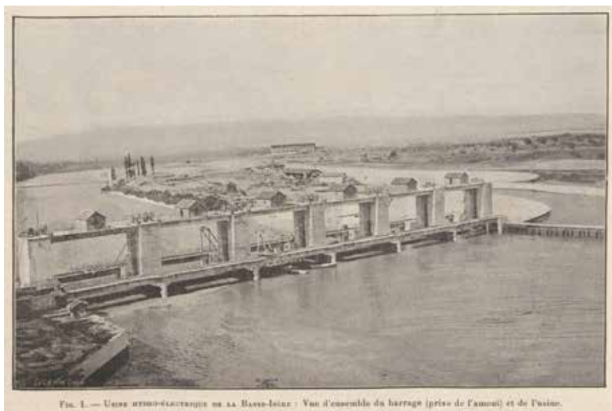
FIG. 1. — Une usine hydro-électrique de la Basse-Isère : Vue d'ensemble du barrage (près de l'amont) et de l'usine.
