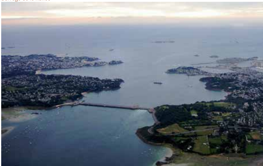
Barrage de la Rance
