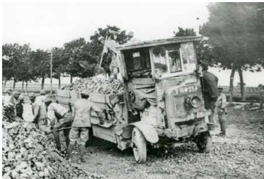
Travaux d'empierrage de la route de Bar-le-Duc à Verdun, 1915. © Fondation Berliet
