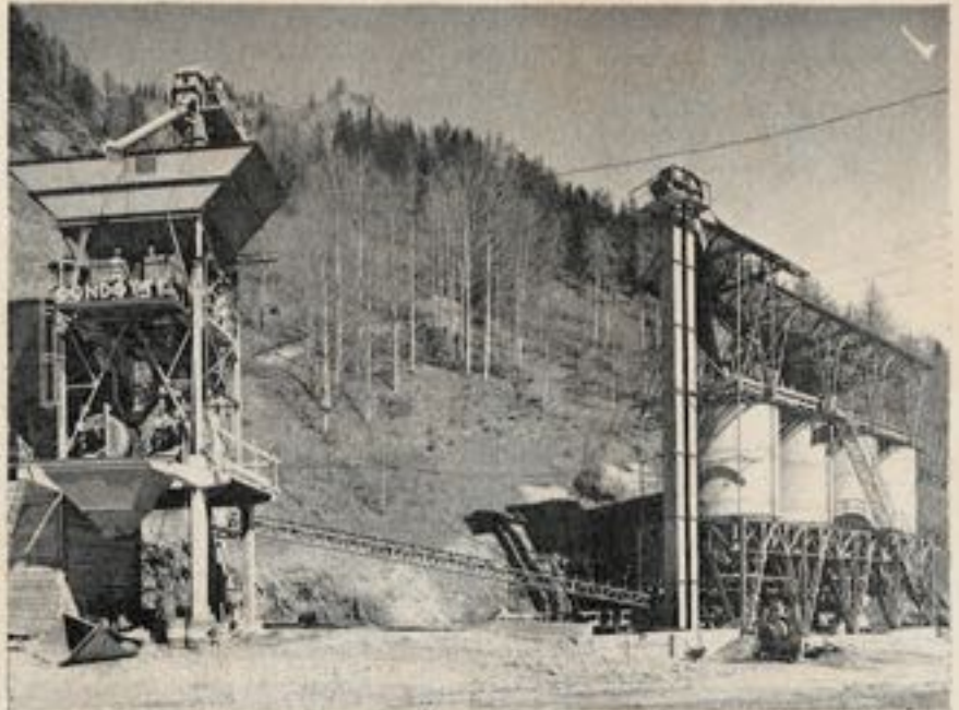
Fig. 22. — Installation de concassage et criblage des agrégats et centrale à béton.
