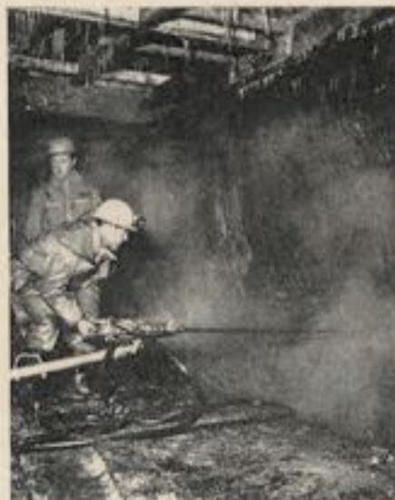
Fig. 12. — Marteau perforateur « Atlas Copco », type Tigre, monté sur poussoir pneumatique rétractable.
