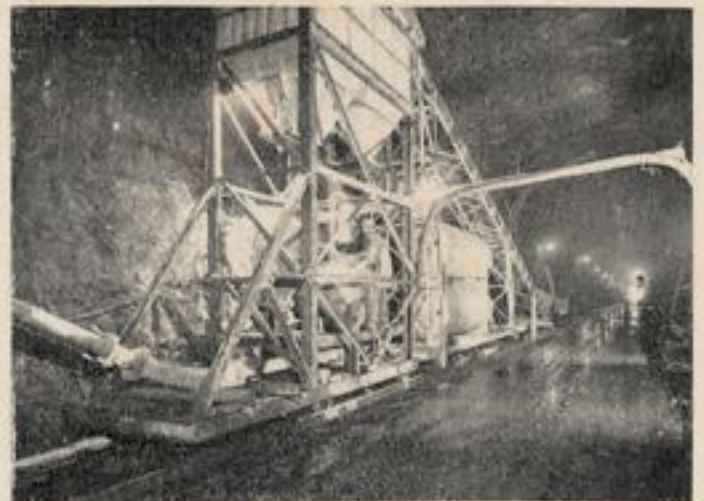
Fig. 18. — Train bétonneur pour la mise en œuvre du béton de revêtement.
