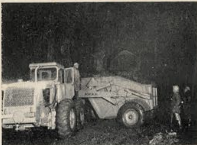
Fig. 17. — Benne de transport de déblais « Moncalvi » avec tracteur Diesel à moteur « Alfa Romeo » de 150 ch.
