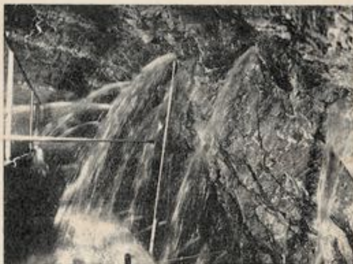
Fig. 2. — En février 1959, venue d'eau au P. K. 368 : débit 350 l/s environ (1).
