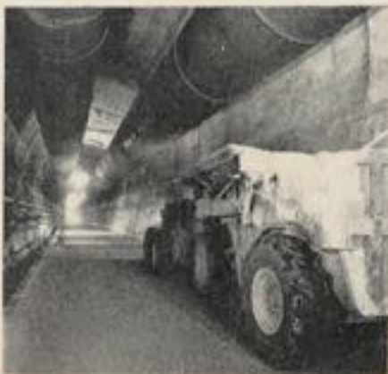
↑ Fig. 19. — Plate-forme portant des coffrages repliables pour le revêtement en béton de la voûte du tunnel.
