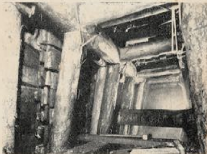
Fig. 3. — Détail de la galerie fortement boisée, traversant sur 99 m l'éboulement qui détruit la plate-forme de perforation.
