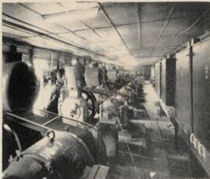
Fig. 21. — Centrale de production d'air comprimé comportant 10 compresseurs « Atlas Copco » AR 4 de 25 000 l/mn chacun.
