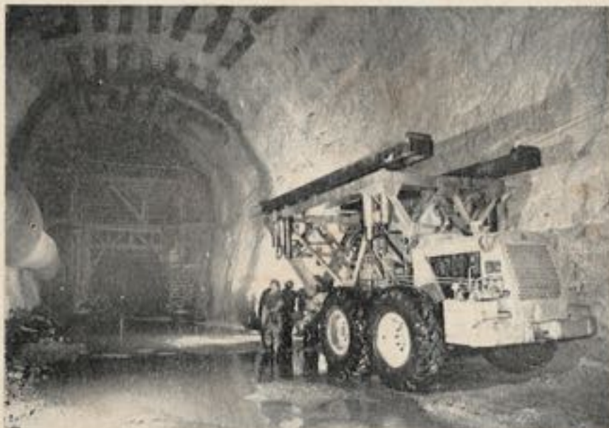
Fig. 15. — Tracteur à 3 essieux avec 6 vérins hydrauliques pour soulever la plate-forme de perforation en vue de son déplacement.
