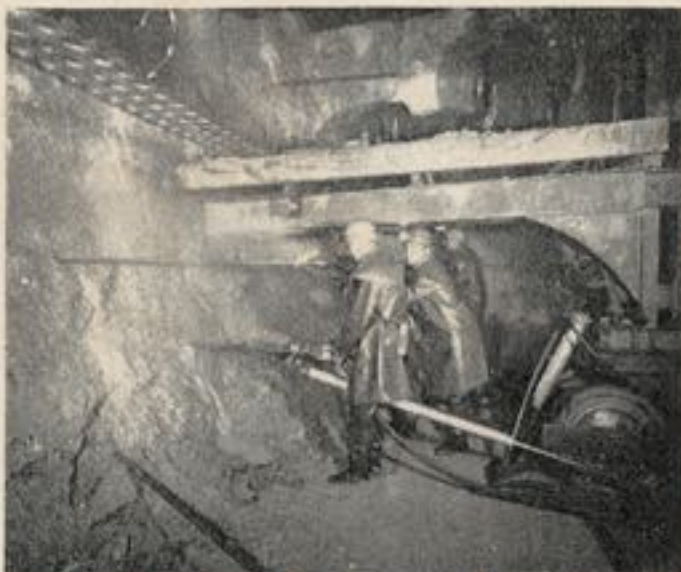
Fig. 13. — Marteaux perforateurs pneumatiques légers « Atlas-Copco », utilisés pendant toute la durée des travaux par l'Entreprise Italienne.
