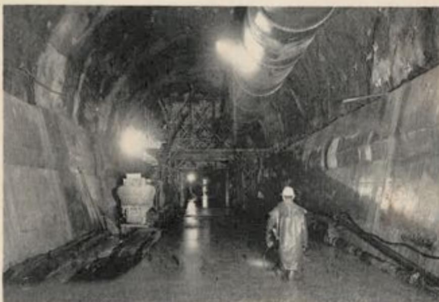
Fig. 9. — Le tunnel inondé par une nappe d'eau de 0,4 m, après la venue d'eau.
