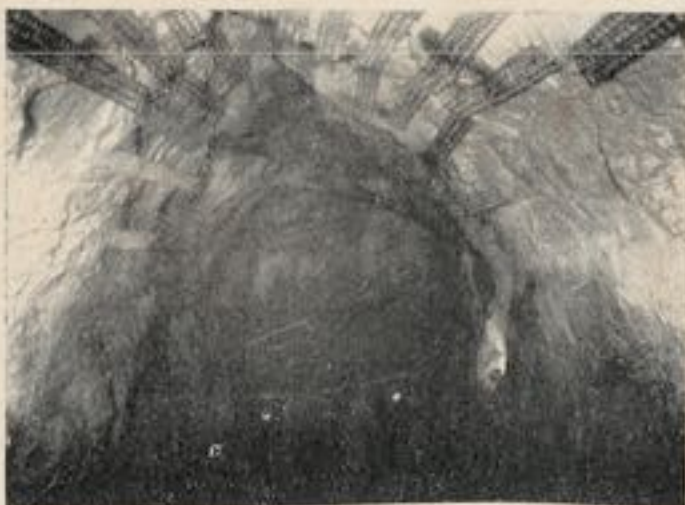
Fig. 4. — Le « coup de terrain ». La galerie perd sa forme circulaire et devient ogivale. Les surépaisseurs correspondantes de maçonnerie atteignent jusqu'à 3 m.
