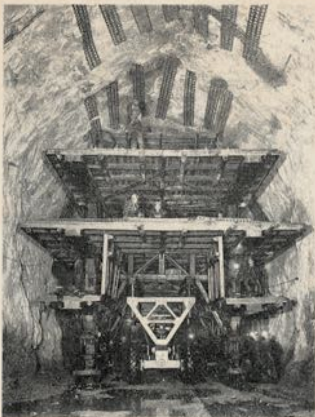
Fig. 14. — Plate-forme de perforation à 4 étages montée sur poutres (poids : environ 40 t).
