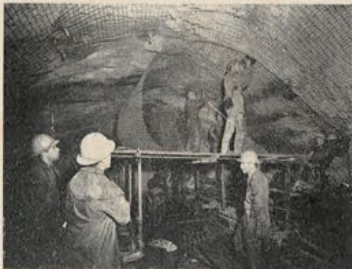
← Fig. 5. — Pose de treillage métallique sur la voûte de la galerie. Entre les P. K. 1304 et 5800, 448 000 kg de treillage.
